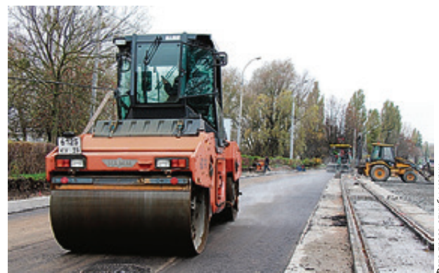
■ Две недели назад здесь начали укладывать асфальт
