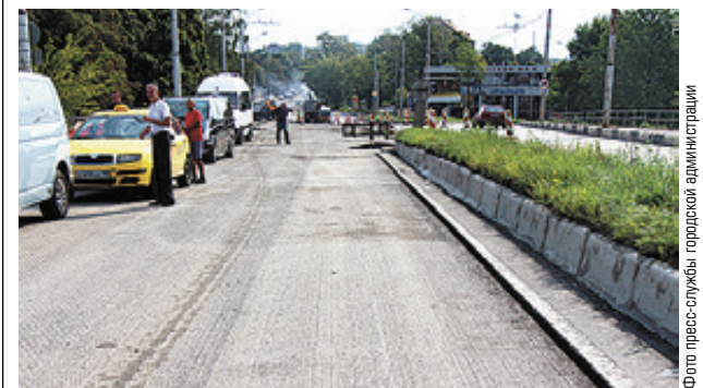
■ Ремонт моста на пр-те Победы
