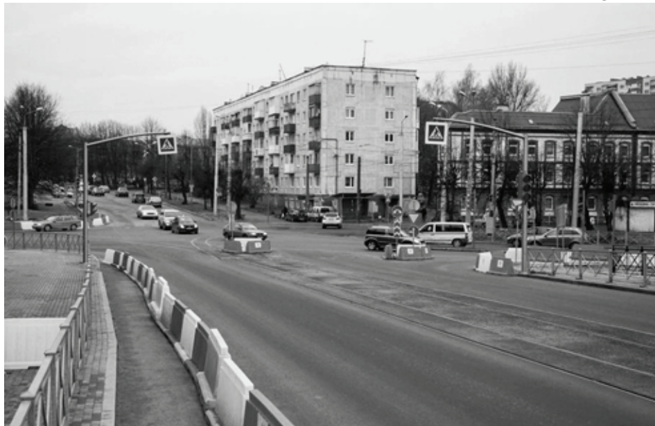
■ Реконструкция путепровода проводилась в рамках подготовки города к чм-2018 по футболу
