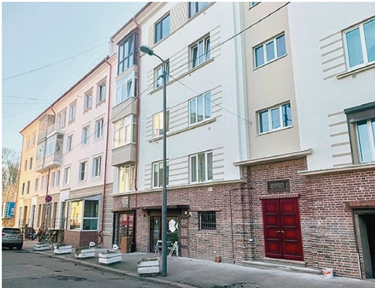
■ Слева - только что отремонтированная хрущевка. Справа - немецкий многоквартирный дом 1920-х годов в Театральном проезде. Все это один дом № 1-3
