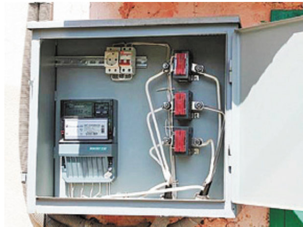
Фото фонда капремонта
