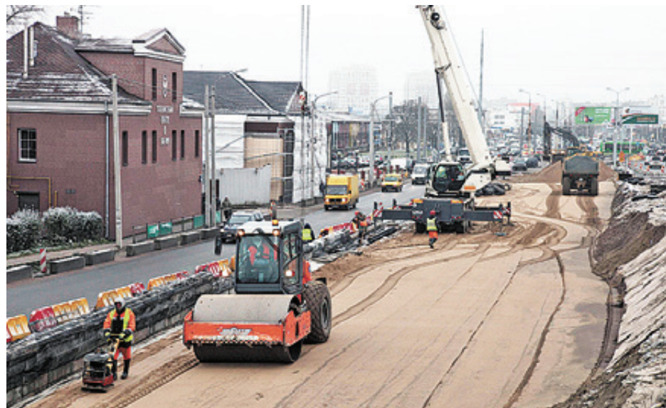
■ Строящийся путепровод - одна из составных частей Восточной эстакады
