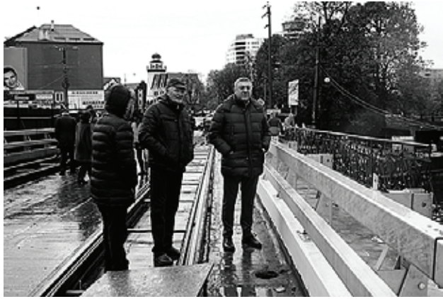
■ Александр Ярошук инспектирует ход ремонтных работ
