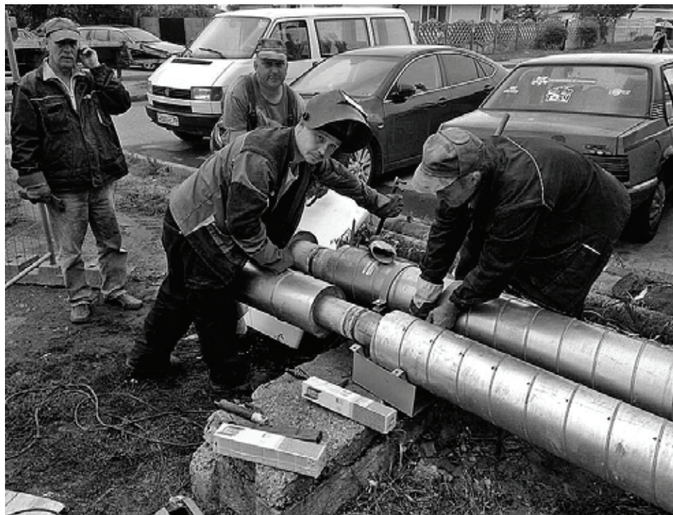
■ Ремонт теплосетей идет полным ходом
