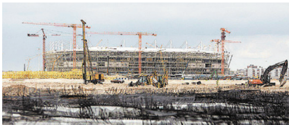
■ Строительство стадиона закончат в феврале 2018 года
