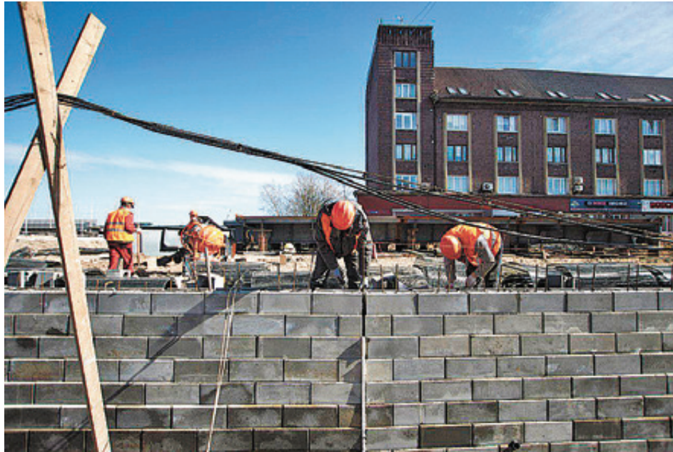
Строительные работы на Высоком мосту
